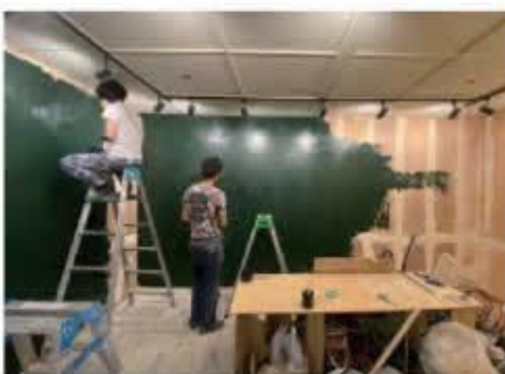
改装中の様子。壁を深緑色に塗り上げました
