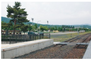
レールも撤去された旧置戸駅ホーム
